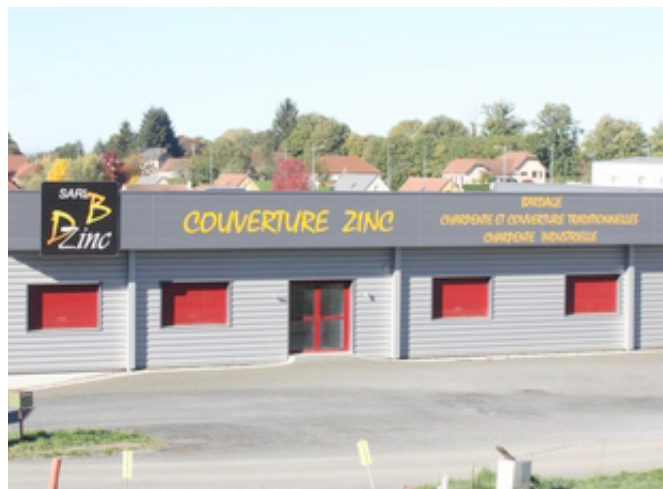
Couverture Charpente Zinguerie Entreprise DB ZINC
