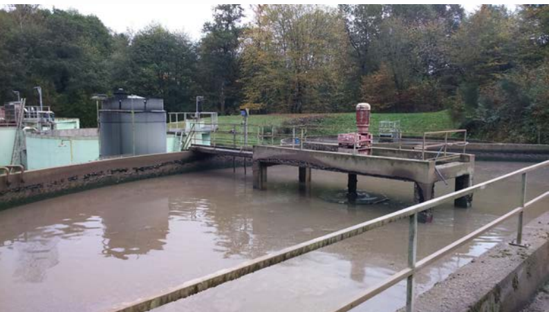
Station d'épuration de Lubersac
